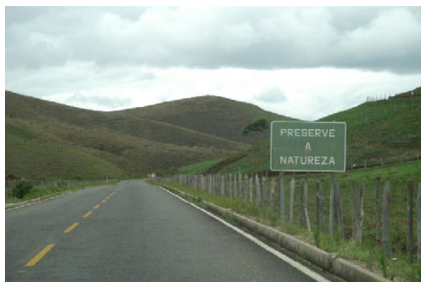
figuras 26 e 27 - Aspecto dos acessos rodoviários ao município. Fonte: Acervo NPEURBMG.
