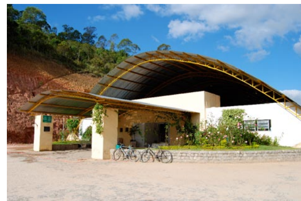
figuras 39 e 40 - Aspecto do centro urbano e vista de quadra coberta. Fonte: Acervo NPEU-RBMG.
